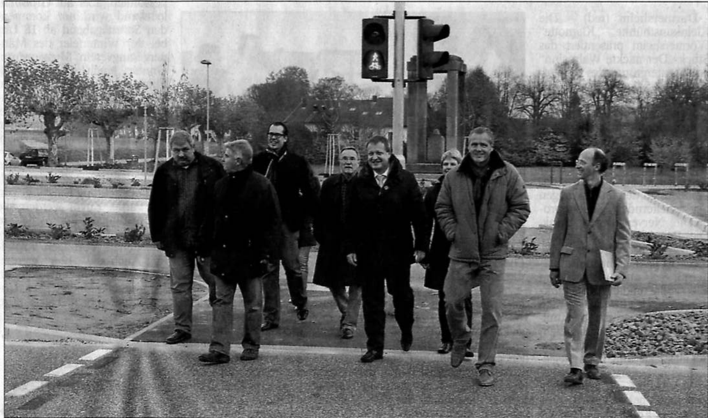
Der neu gestaltete Parkplatz beim Kuppenheimer Kriegerdenkmal (im Hintergrund) und die neue Ampel sind gestern offiziell ihrer Bestimmung übergeben worden.
